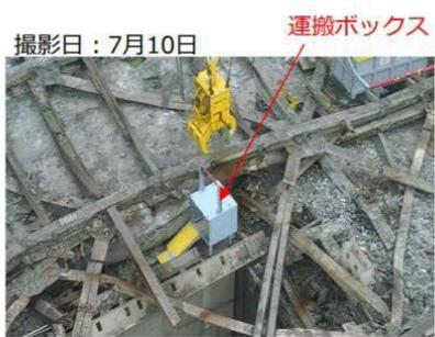
写真① 運搬ボックス設置状況
