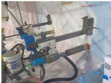
コア削孔装置設置状況
