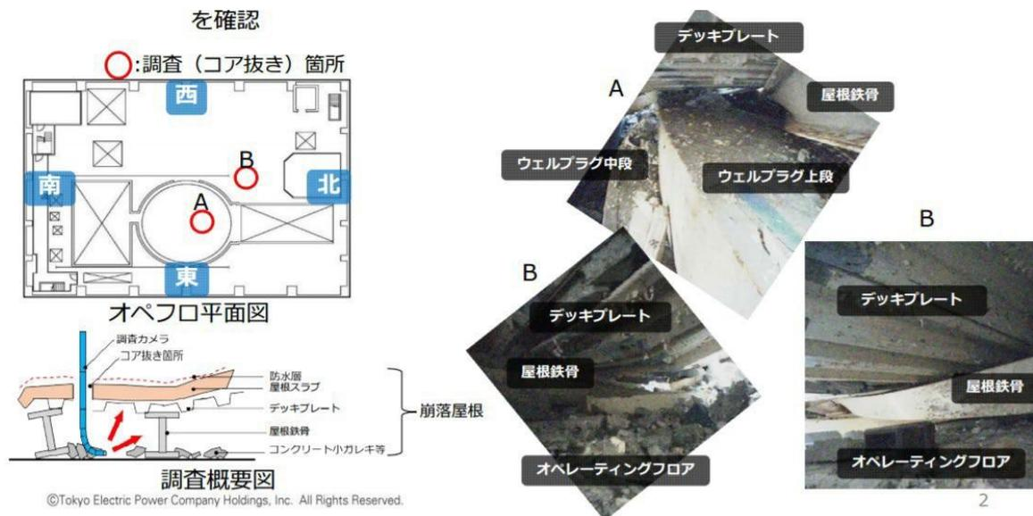
東京電力によると、これまで調査した屋根鉄骨はほぼ原型をとどめており、切断によって撤去ができることが確認できたとのことです。しかし屋根スラブが崩れ小ガレキとなっている箇所も確認され、今後小ガレキを吸引し、屋根鉄骨の調査を進めるということです。
