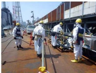
写真③ ケーブル敷設作業状況
