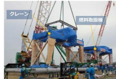
燃料取扱機・クレーンの海上から構内に搬入状況
