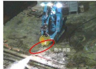
① 散水状況 (ダスト抑制対策)
