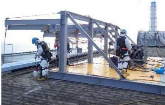
架台設置状況（原子炉建屋屋上）
