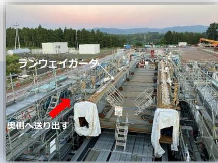
燃料取扱設備・クレーンを構台と使用済み核燃料プールの間で移動させるレールを載せる橋げた
