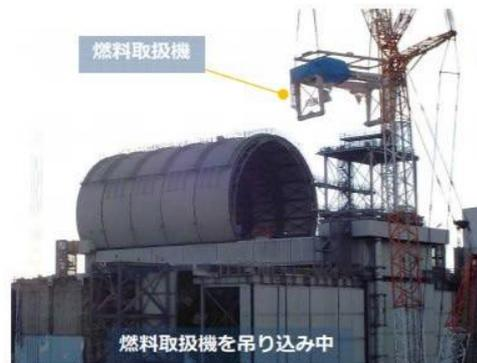
燃料取扱機、ガーダ上への設置状況
