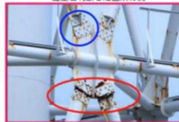
破断及び変形と判断した箇所の例
