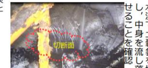
土嚢袋切断の作業状況
