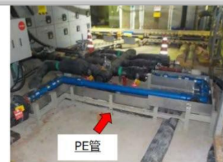
新規PE管施工後
