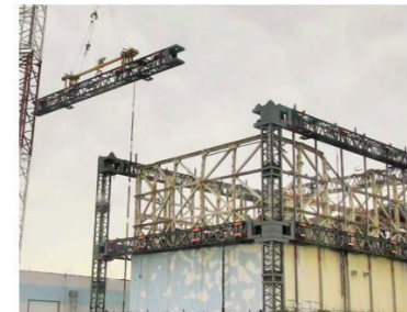
上部解体時の梁取り外し状況 撮影：2017.7
