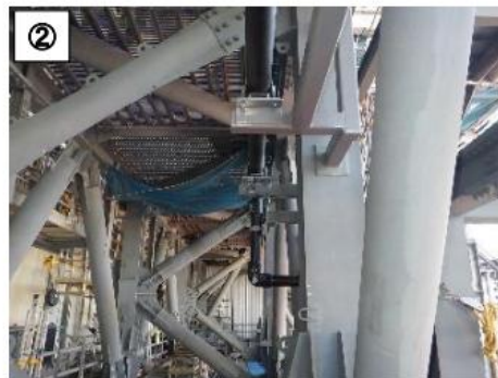
代替注水ライン設置状況 (撮影：2月26日)
