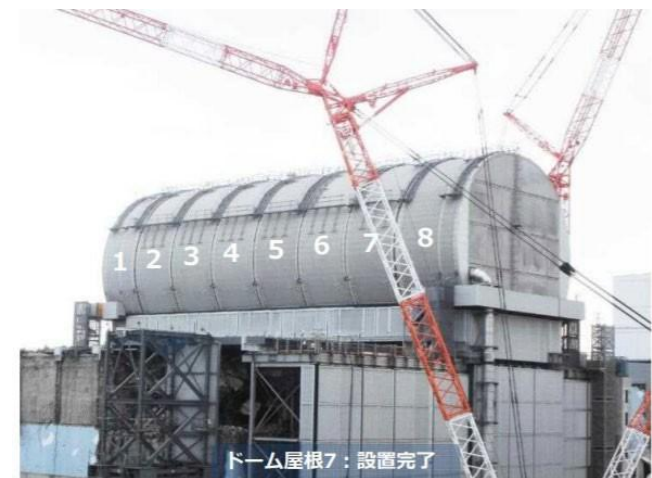
ドーム屋根7設置完了 (撮影日2018年2月28日)
