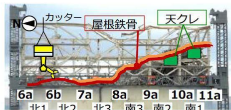
図1 崩落屋根形状(西面より)
