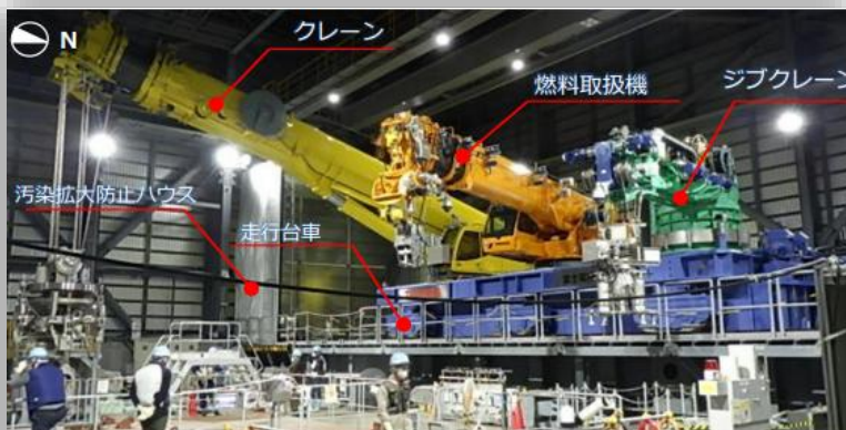
2025年9月8日 燃料取扱設備全景
