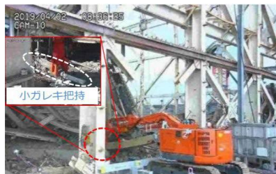
遠隔操作重機による作業状況
