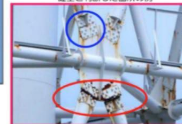
破断及び変形と判断した箇所の例
