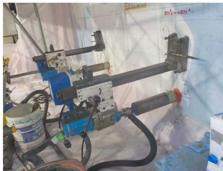
コア削孔装置設置状況
