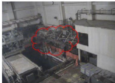
⑤干渉物撤去(SFP南側既設設備撤去) ※4
