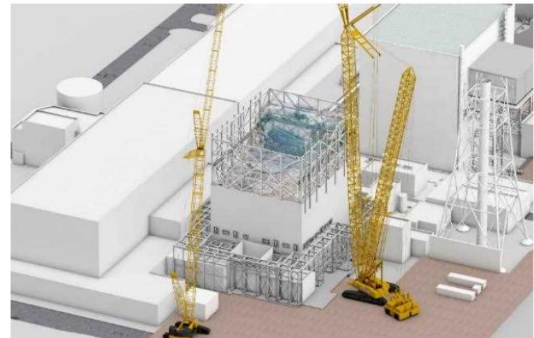
仮設構台設置完了
