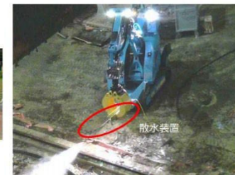
① 散水状況 (ダスト抑制対策)
