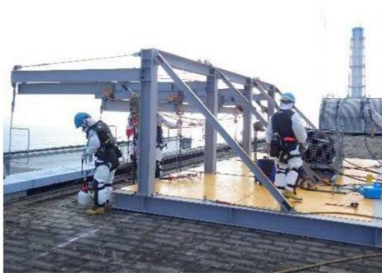
架台設置状況（原子炉建屋屋上）
