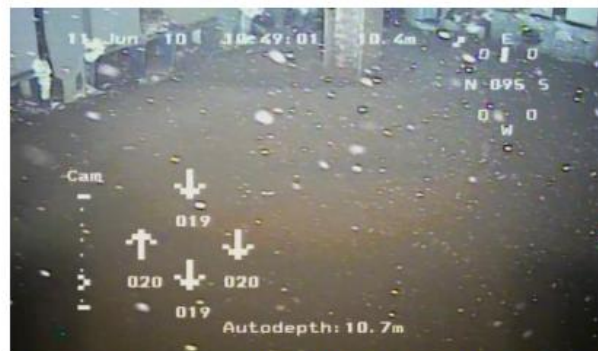
キヤスクピット底部に砂状のものが堆積した様子
