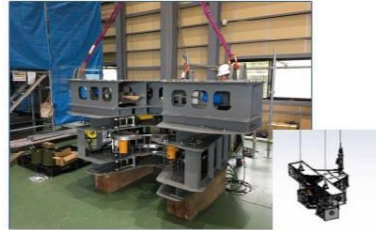
鉄塔解体装置（主柱材用）組立状況
