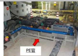
新規PE管施工後
