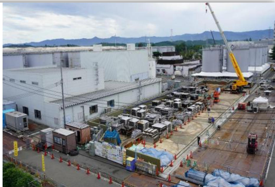
<解体作業が完了したJ9エリア> (9月3日午前8時30分頃 撮影)
