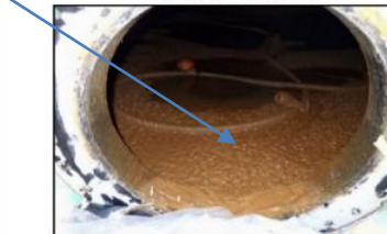
側板マンホールから内部撮影
