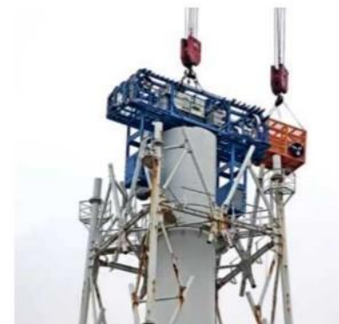
搭乗設備 作業状況
