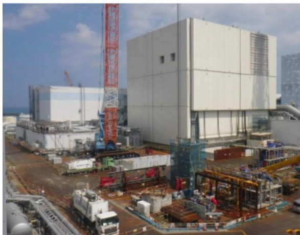
作業開始前の状況写真(2016年7月11日撮影)
