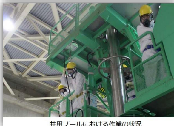
共用プールにおける作業の状況
