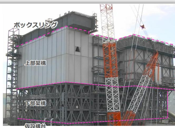
現場状況(北西面) (撮影: 2025年9月23日)
