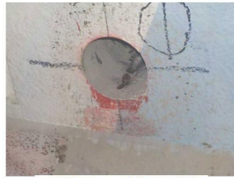
調査用コア採取の状況
