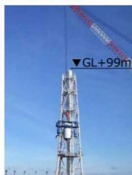
9ブロック解体後 (2020年1月17日)
