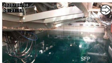
養生バッグ投入前 (撮影日: 2020.6.8)
