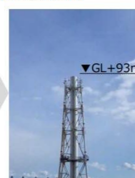
11ブロック解体後 (2020年2月4日)
