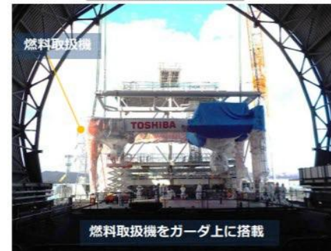
燃料取扱機・クレーンの海上から構内に搬入状況 (撮影日2017年11月8日)
