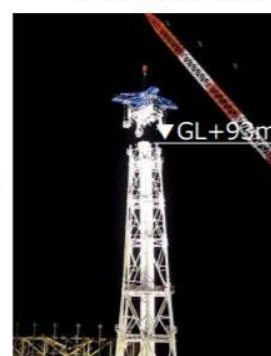
11ブロック解体時 (2020年2月1日)
