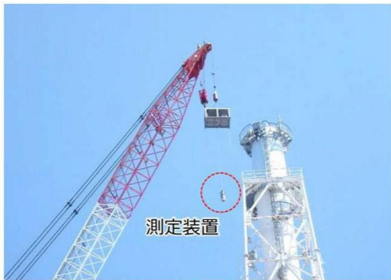
解体前調査の実施状況
