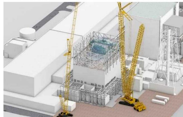
仮設構台設置完了
