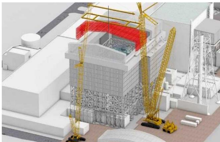
可動屋根設置中
