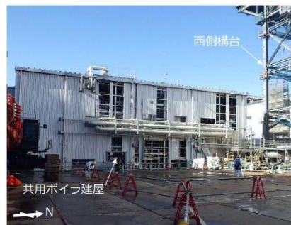
共用ボイラ建屋解体前 (2019年12月撮影)
