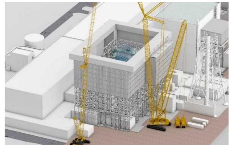
ボックスリング設置完了
