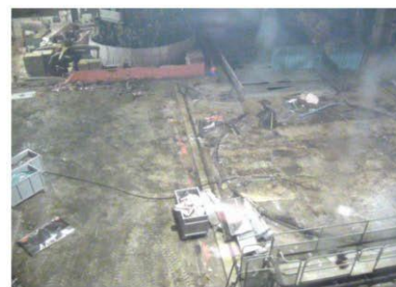
② 残置物片付後 (北側) 撮影日(10/22)
