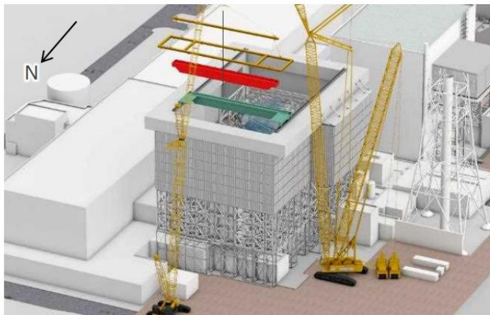
ガレキ撤去用天井クレーン設置中
