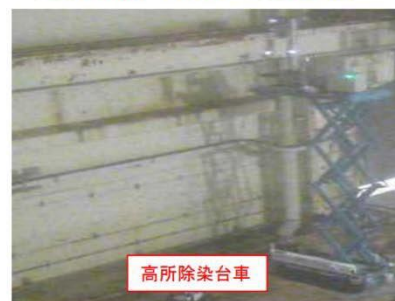
⑤高所空間／表面線量率測定状況
