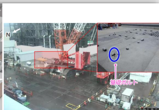
1号機原子炉建屋北西ヤード (撮影: 2025年09月11日)
