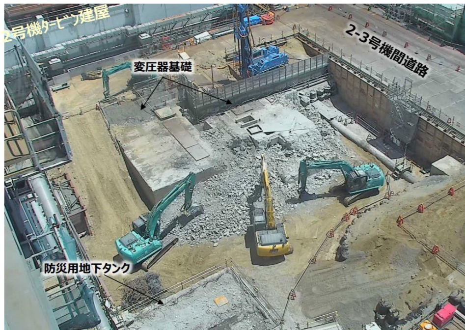
2号機原子炉建屋南側ヤード状況（撮影日：2021年7月17日）
