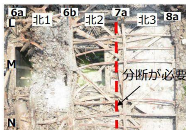
図3 オペフロ7a通り周辺状況
