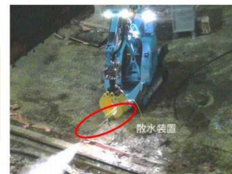
① 散水状況 (ダスト抑制対策)
