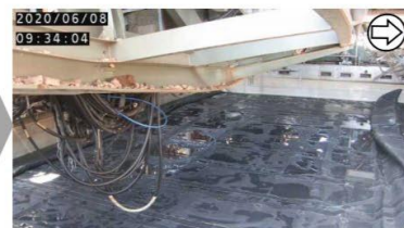
養生バッグ展張 (撮影日: 2020.6.8)
