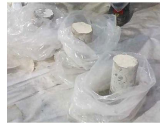
調査用コア採取状況
