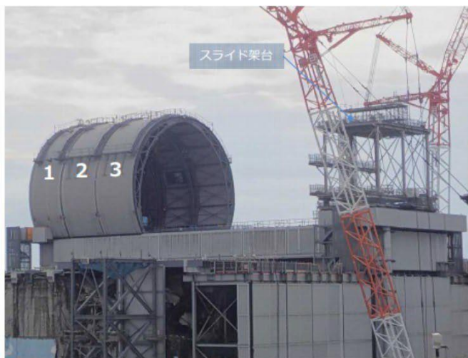
ドーム屋根設置状況 (撮影日:2017年10月17日)
