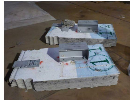
壁解体 (STEP6) 2018/5/28撮影
