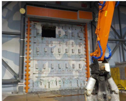
壁解体(STEP6) 2018/5/28撮影
