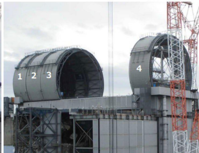
ドーム屋根設置状況 (撮影日:2017年10月25日)
