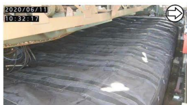
エアモルタル充填 (撮影日: 2020.6.11)
