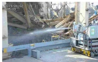
飛散防止剤散布状況
