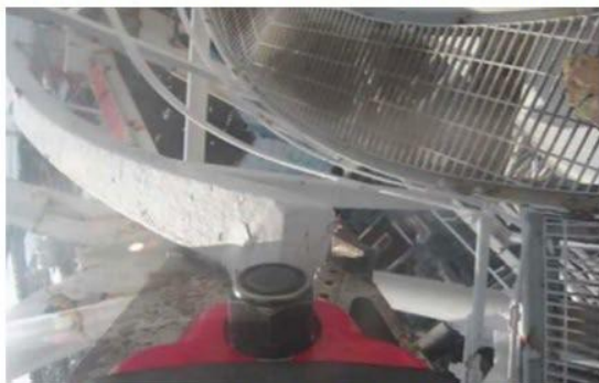
12ブロック目鉄塔解体作業(2月24日)
