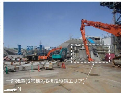
共用ボイラ建屋解体後(2020年3月撮)
