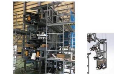
鉄塔解体装置（斜材用）組立状況
