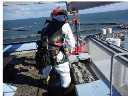
屋上での笠木撤去状況
