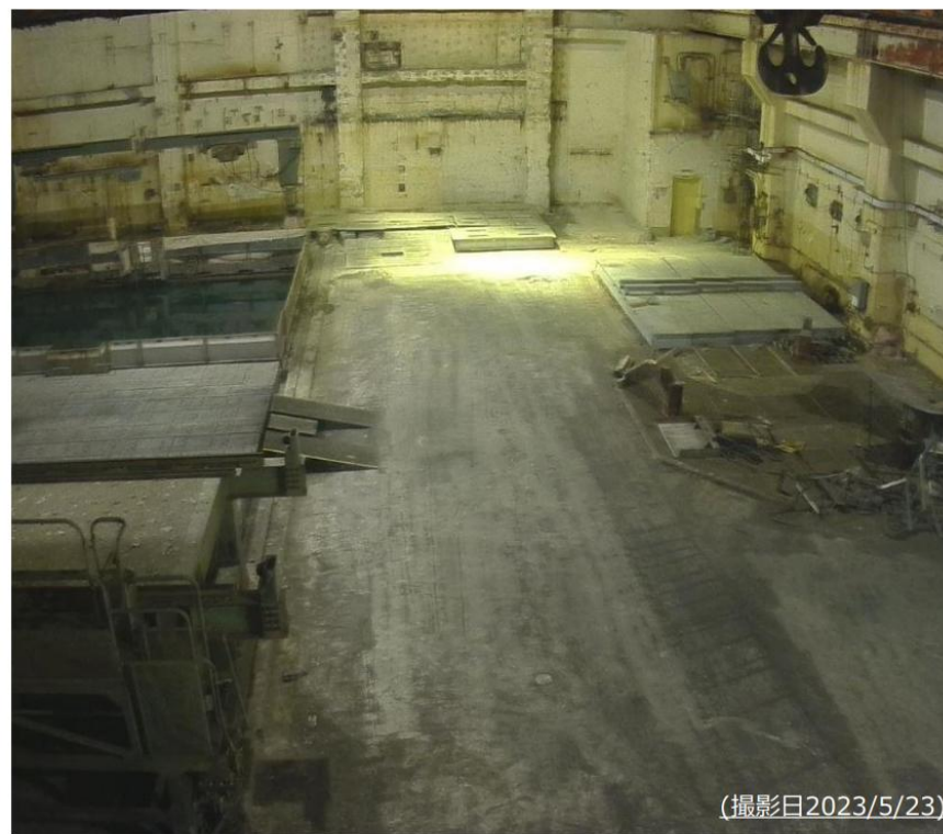
作業進捗状況
