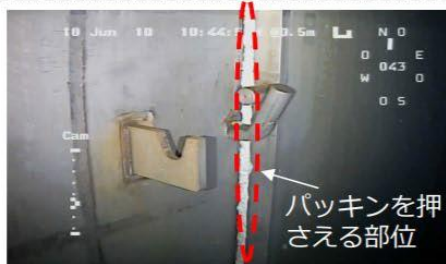
プールゲート支持軸の様子
