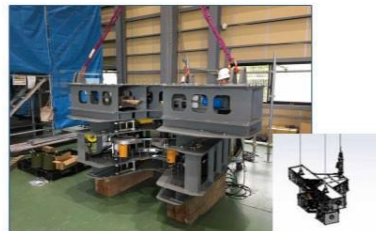
鉄塔解体装置（支柱材用）組立状況
