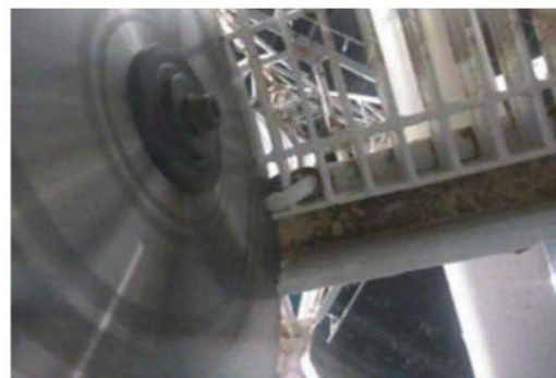
12ブロック目鉄塔解体作業(2月24日)
