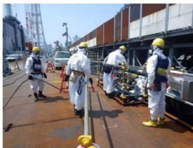
写真③ ケーブル敷設作業状況
