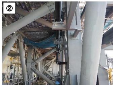
代替注水ライン設置状況 (撮影：2月26日)
