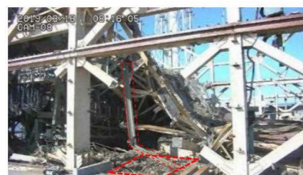
小ガレキ撤去前
