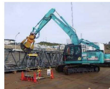
上部解体時の小割解体状況 撮影：2017.4
