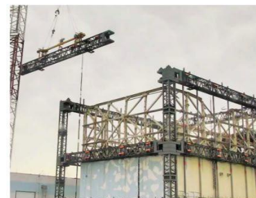
上部解体時の梁取り外し状況 撮影：2017.7
