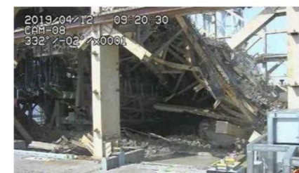
小ガレキ撤去状況
