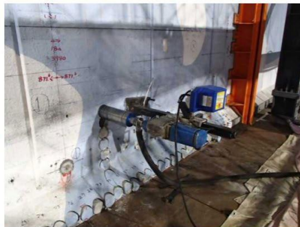
解体用コア削孔 (STEP3) 2018/4/24撮影
