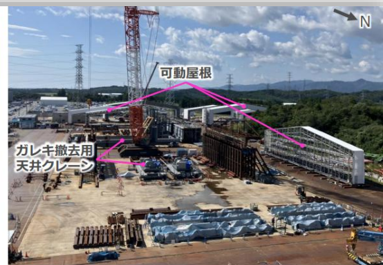
構外西門前ヤード (撮影: 2025年9月16日)
