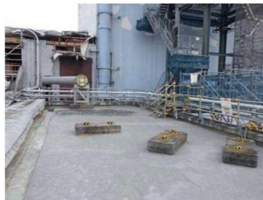
FSTR建屋片付け状況
