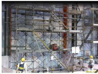
調査用コア採取の作業状況(全景)
