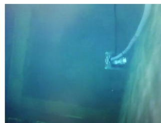
2025年10月21日 キャスクピットに水中清掃ロボットを投入する様子
