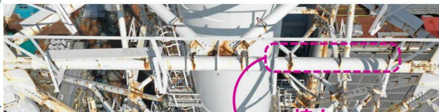
【写真①】 地上約76mの南側水平材
