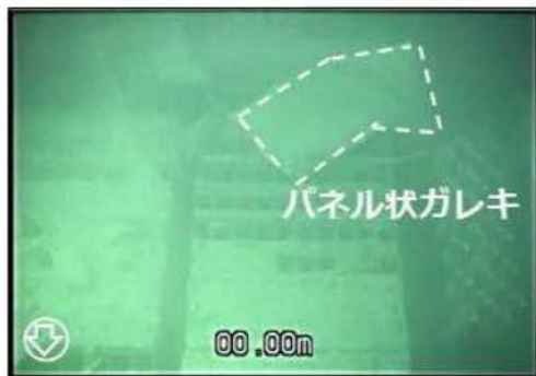
写真① (水中1m 斜め下方向)
