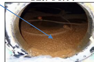
側板マンホールから内部撮影
