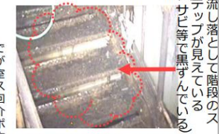
階段室内の作業状況 (作業後)
