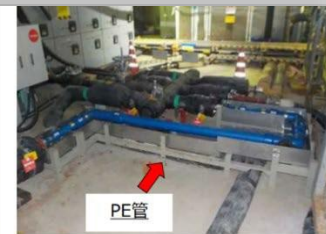
新規PE管施工後
