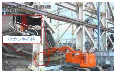
遠隔操作重機による作業状況
