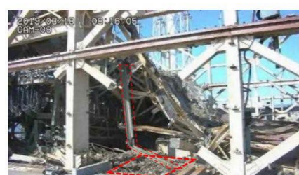
小ガレキ撤去前
