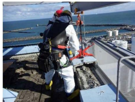
屋上での桁木撤去状況
