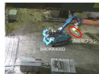
② 床面清掃状況
