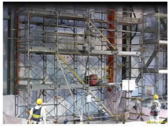
調査用コア採取の作業状況(全景)
