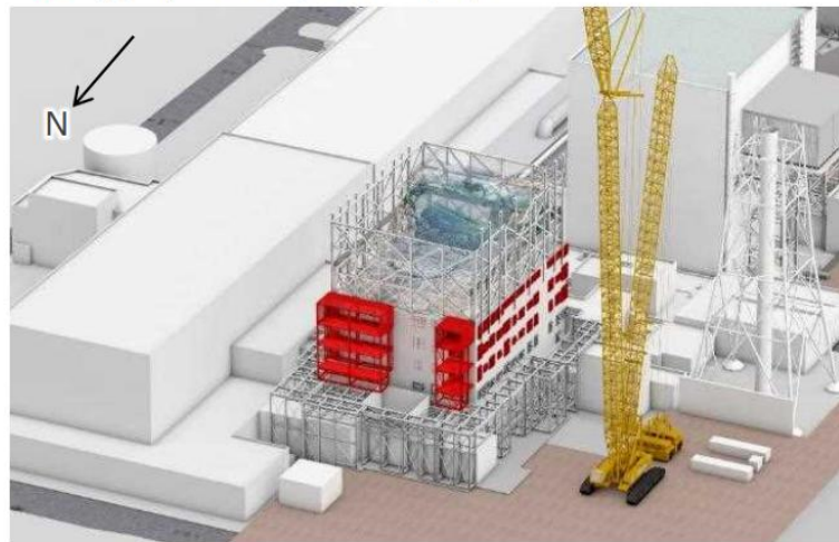
アンカー・ベースプレート設置中
