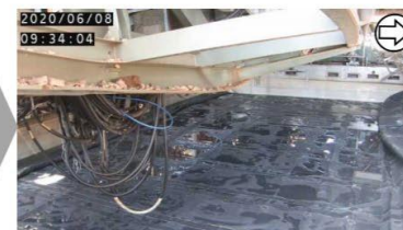
養生バッグ展張 (撮影日: 2020.6.8)
