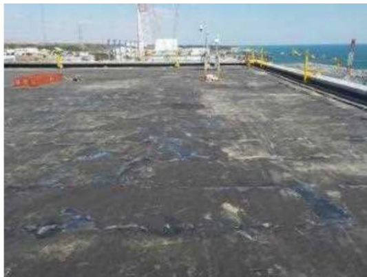
2R/B上屋対策状況
