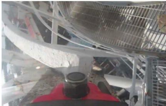
12ブロック目鉄塔解体作業(2月24日)
