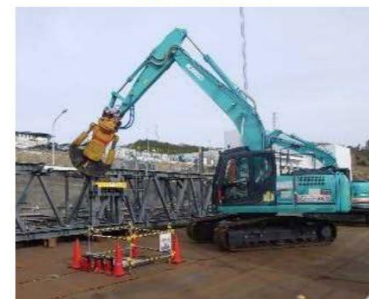
上部解体時の小割解体状況 撮影：2017.4
