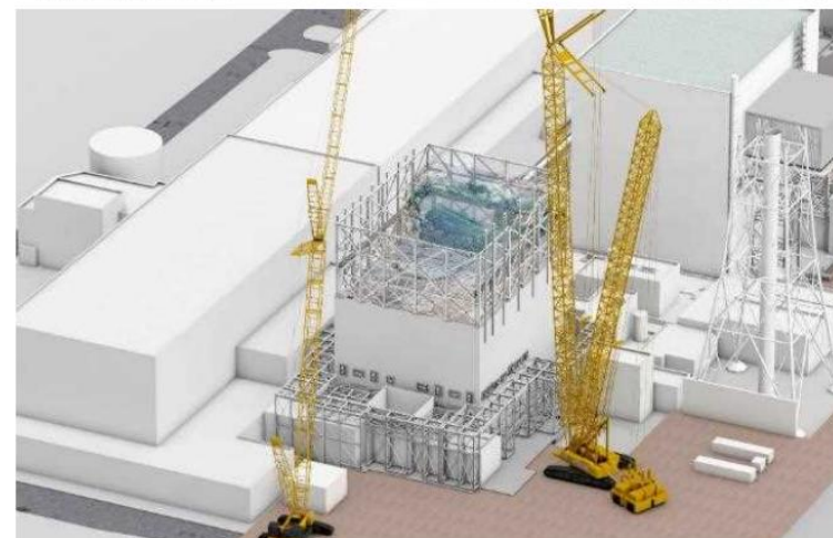
仮設構台設置完了
