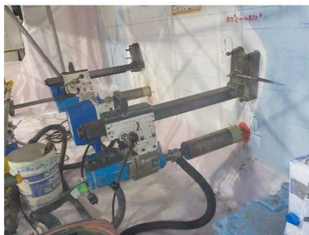
コア削孔装置設置状況
