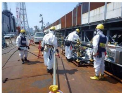
写真③ ケーブル敷設作業状況
