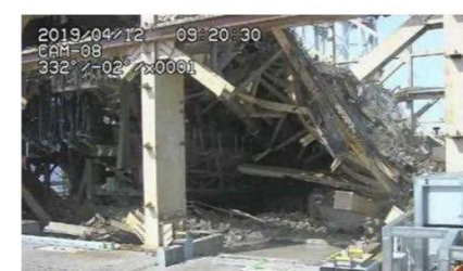
小ガレキ撤去状況
