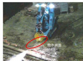
① 散水状況 (ダスト抑制対策)
