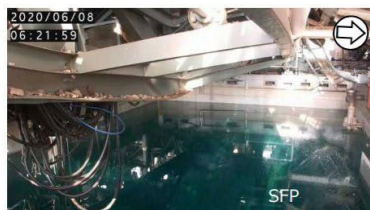
養生バッグ投入前 (撮影日: 2020.6.8)
