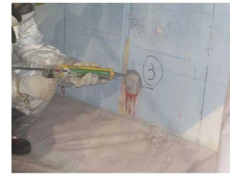
調査箇所の孔塞ぎ状況
