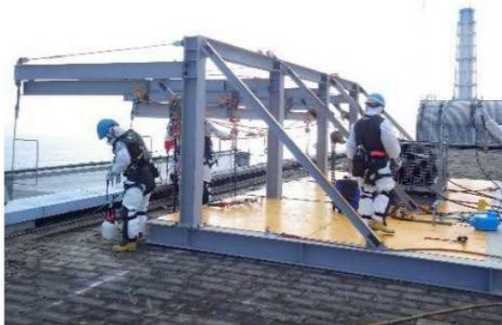
架台設置状況（原子炉建屋屋上）
