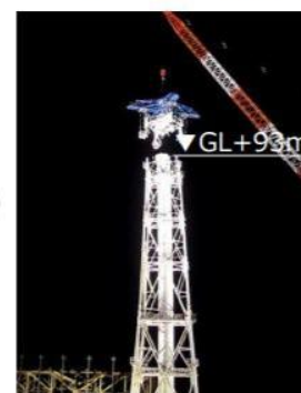
11ブロック解体時 (2020年2月1日)
