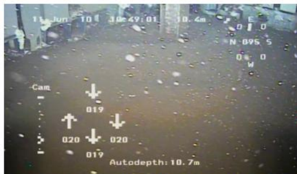
キャスクピット底部に砂状のものが堆積した様子
