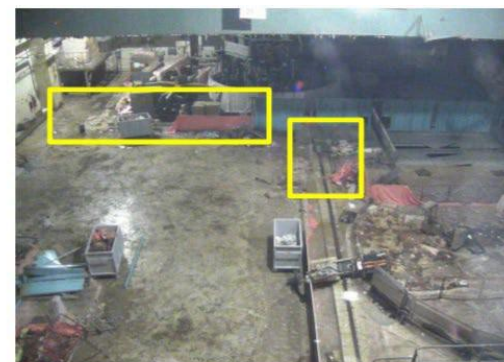
②残置物移動片付後 (北側)
