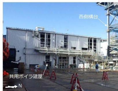
共用ボイラ建屋解体前 (2019年12月撮影)
