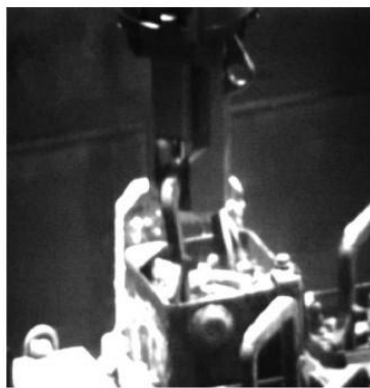
吊り上げ試験の状況 (No.⑮※)
