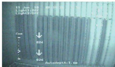
制御棒、制御棒ハンガー全体の様子
