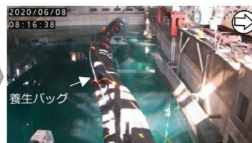
養生バッグ投入 (撮影日: 2020.6.8)
