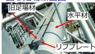
【参考】 改造工事前の足場写真 (昭和61年撮影)
