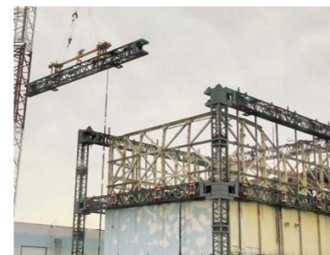
上部解体時の梁取り外し状況 撮影：2017.7
