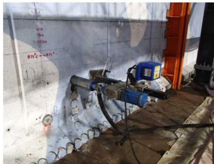
解体用コア削孔 (STEP3) 2018/4/24撮影
