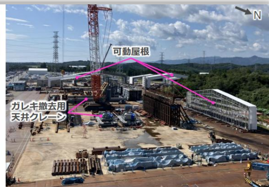
構外西門前ヤード (撮影: 2025年9月16日)
