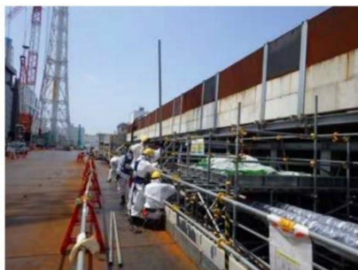
写真② 無線通信用アンテナ架台設置状況
