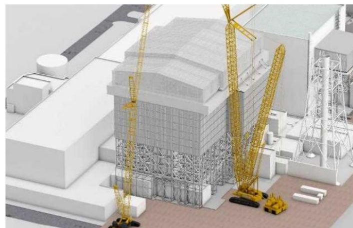
可動屋根設置完了
