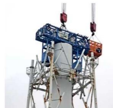
搭乗設備 作業状況
