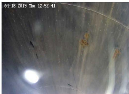
筒身内部調査の実施状況写真
