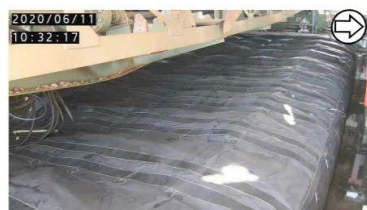
エアモルタル充填 (撮影日: 2020.6.11)
