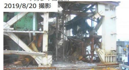
南側小ガレキ撤去後
