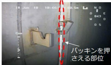
プールゲート支持軸の様子
