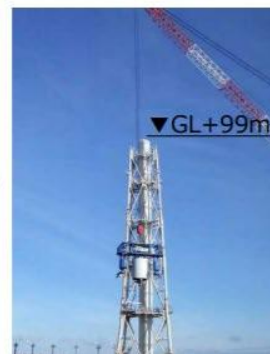
9ブロック解体後 (2020年1月17日)
