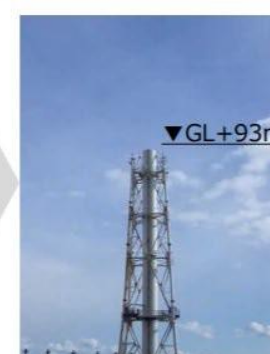
11ブロック解体後 (2020年2月4日)
