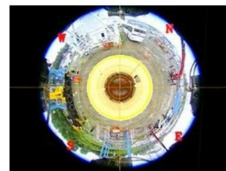
装置据付け時のカメラ画像
