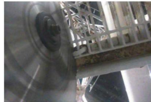
12ブロック目鉄塔解体作業(2月24日)
