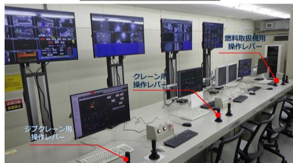
2025年8月22日 遠隔操作室設置状況
