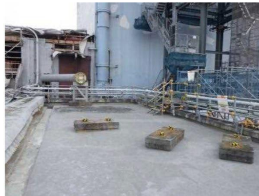
FSTR建屋片付け状況
