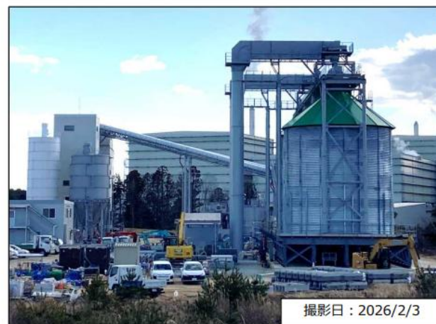
コンクリートプラント全景
