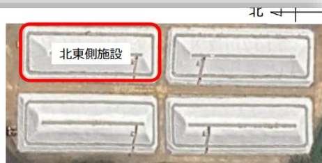
図2. 一時保管エリアLの上空写真
