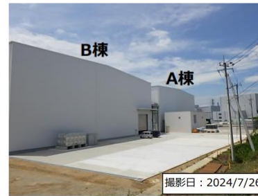
10-A・B棟の外観
