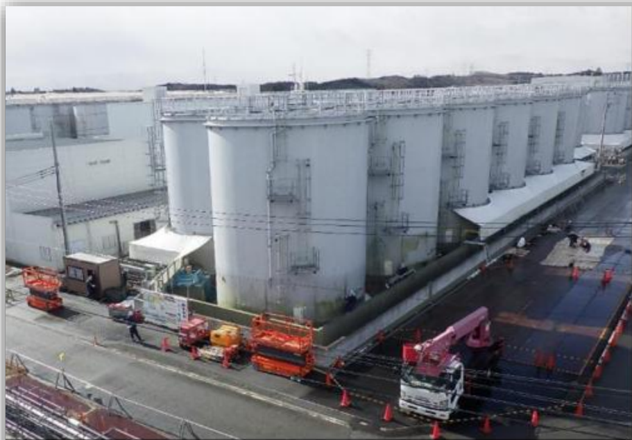
<解体作業着手前のJ9エリア> (2月13日 撮影)
