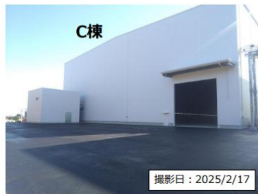
10-C棟の外観
