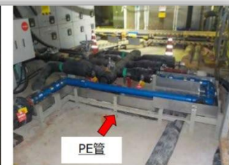
新規PE管施工後
