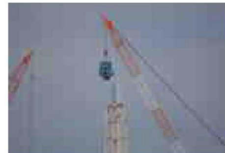
<頂部ブロック吊り下げ>
