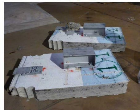
壁解体 (STEP6) 2018/5/28撮影
