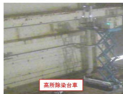
⑤高所空間／表面線量率測定状況
