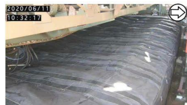
エアモルタル充填（撮影日：2020.6.11）
