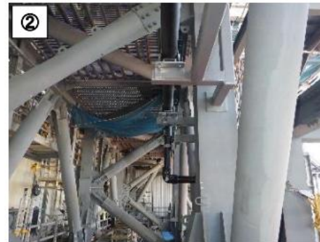
代替注水ライン設置状況 (撮影：2月26日)
