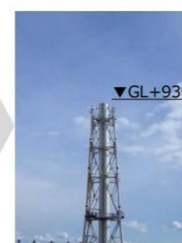
11ブロック解体後 (2020年2月4日)
