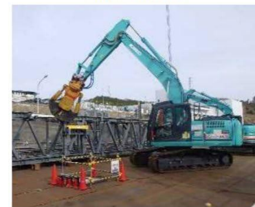
上部解体時の小割解体状況 撮影：2017.4
