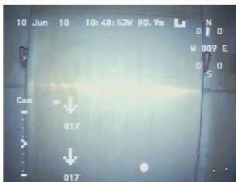
プールゲート正面の様子
