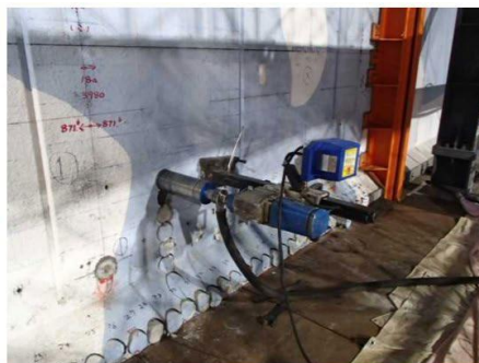
解体用コア削孔 (STEP3) 2018/4/24撮影
