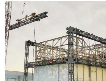
上部解体時の梁取り外し状況 撮影：2017.7
