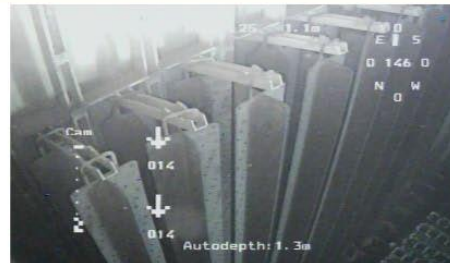
制御棒ハンガー（北東側）の様子
