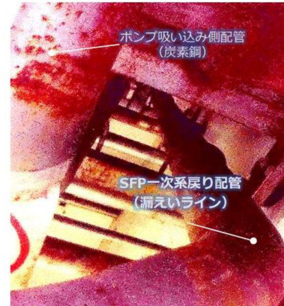
①SFP一次系戻り配管配管上部
