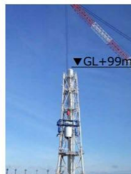
9ブロック解体後 (2020年1月17日)
