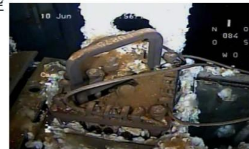
ワイヤー修復燃料上部の様子
