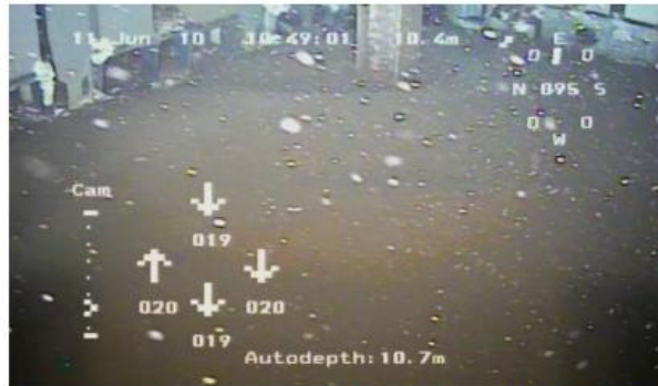
カスクピット底部に砂状のものが堆積した様子
