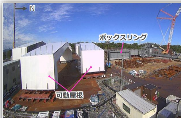
構外西門前ヤード (撮影: 2025年9月19日)
