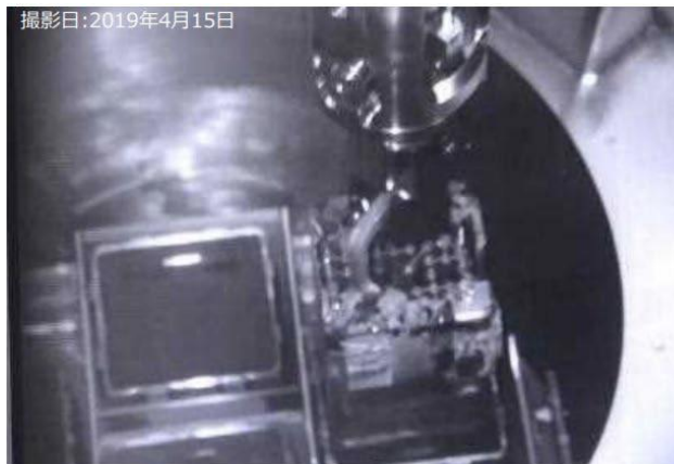
輸送容器へ燃料装填(1体目)
