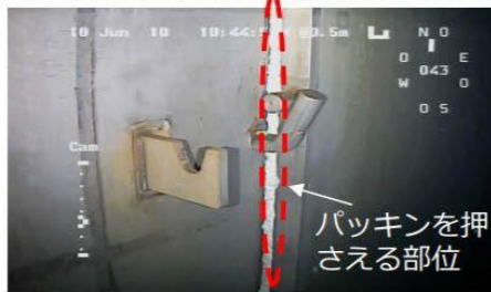
プールゲート支持軸の様子
