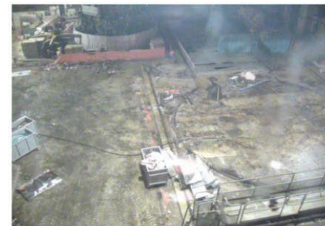
②残置物片付後（北側）撮影日(10/22)
