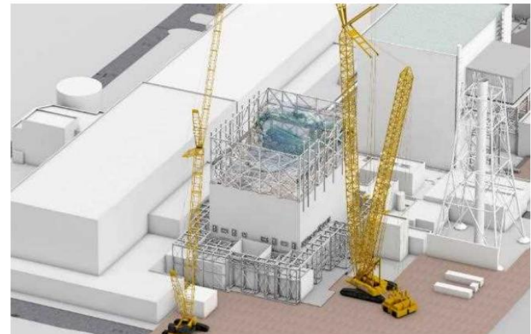
仮設構台設置完了
