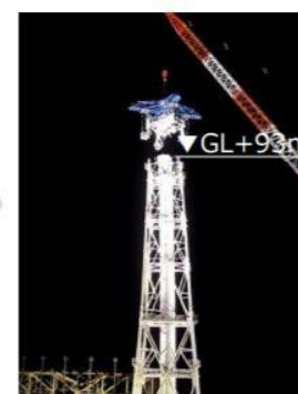
11ブロック解体時 (2020年2月1日)
