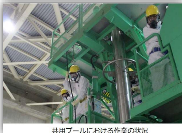
共用プールにおける作業の状況
