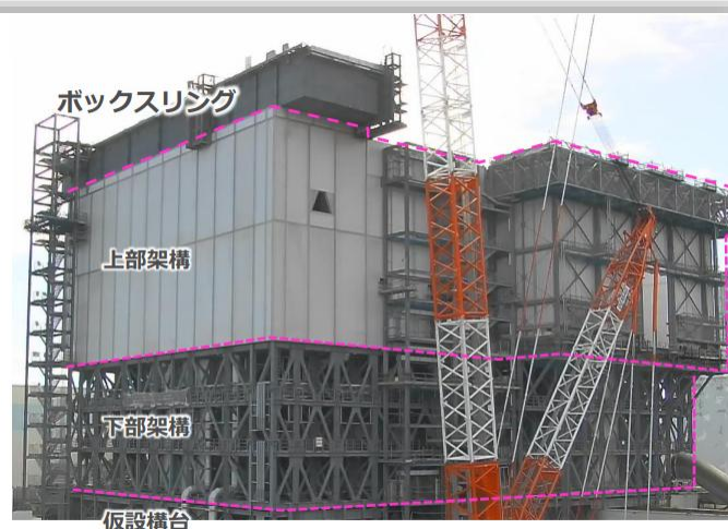
現場状況（北西面）（撮影：2025年9月23日）
