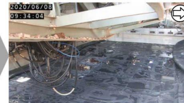
養生バッグ展張（撮影日：2020.6.8）
