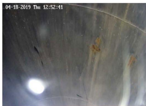
筒身内部調査の実施状況写真
