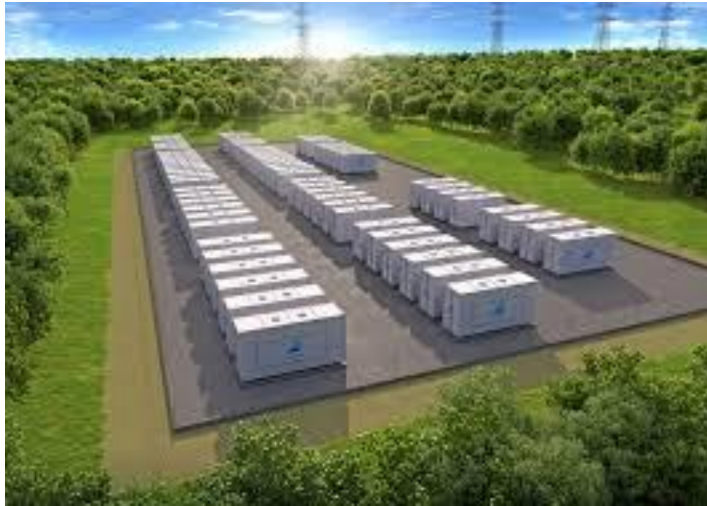
出力調整用の蓄電所
