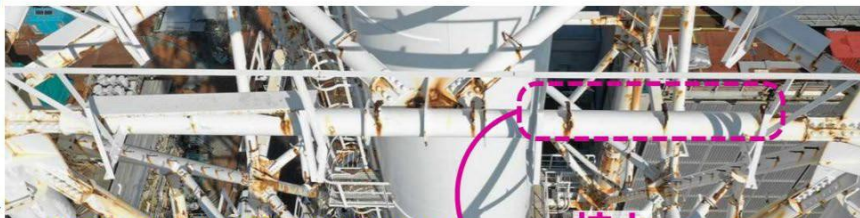
【写真①】地上約76mの南側水平材
