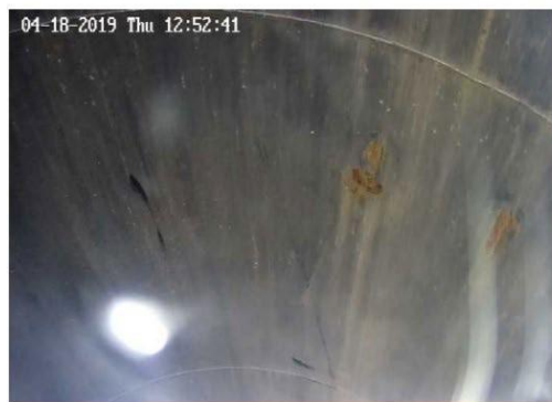
筒身内部調査の実施状況写真
