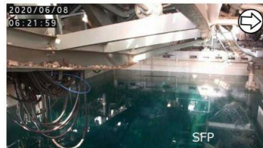
養生バッグ投入前（撮影日：2020.6.8）
