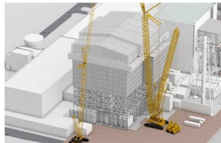
可動屋根設置完了
