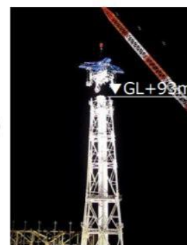
11ブロック解体時 (2020年2月1日)
