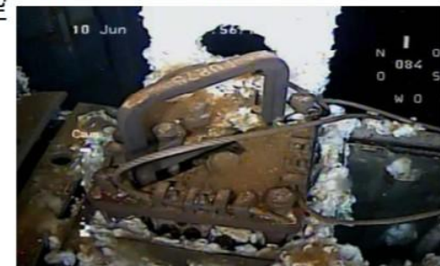
ワイヤー修復燃料上部の様子
