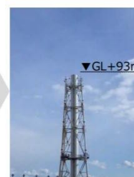
11ブロック解体後 (2020年2月4日)
