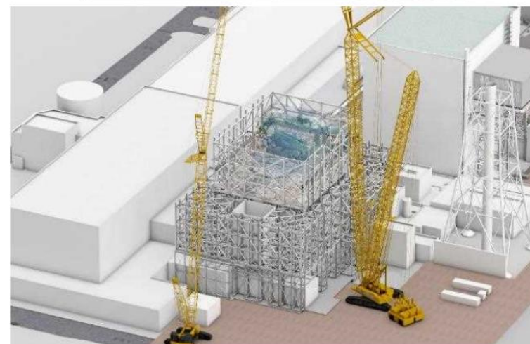
下部架構設置完了
