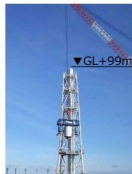
9ブロック解体後 (2020年1月17日)
