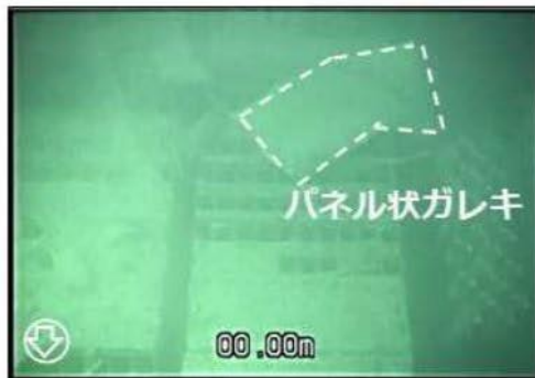
写真① (水中1m 斜め下方向)
