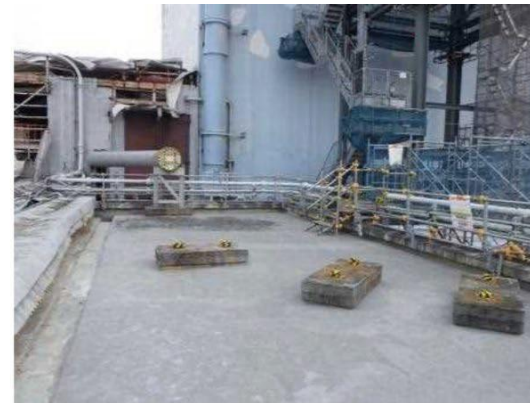
FSTR建屋片付け状況
