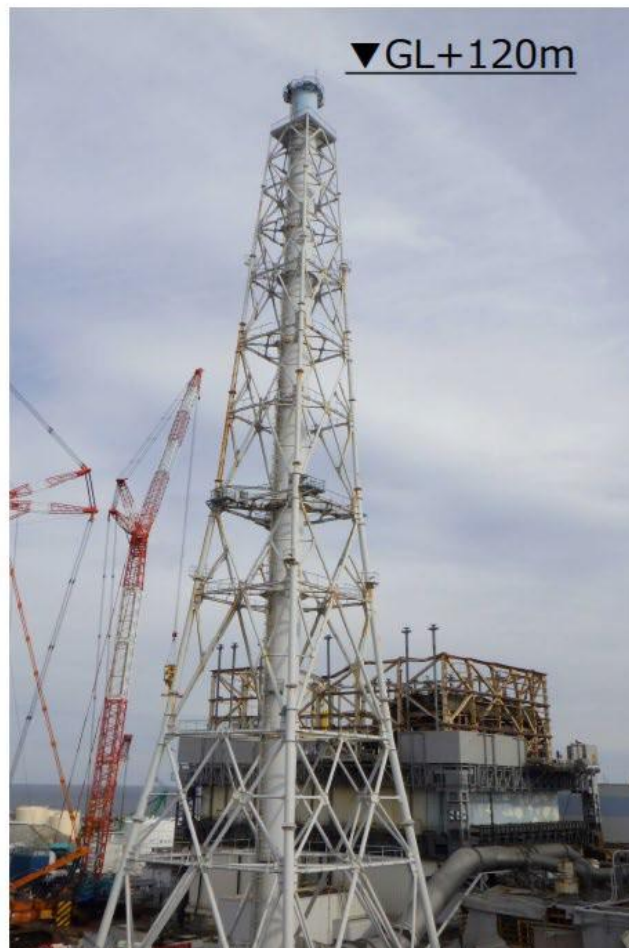
解体開始前 (2019年7月)
