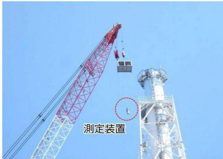
解体前調査の実施状況
