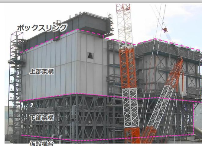
現場状況（北西面）（撮影：2025年9月23日）
