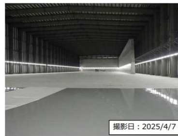
10-C棟の内部
