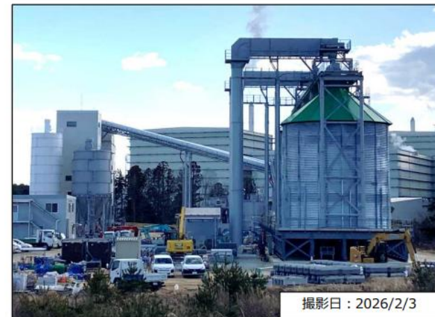
コンクリートプラント全景
