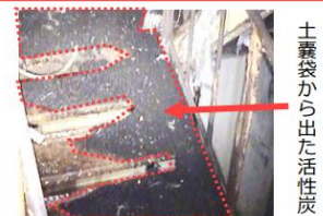
階段室内の作業状況（作業前）
