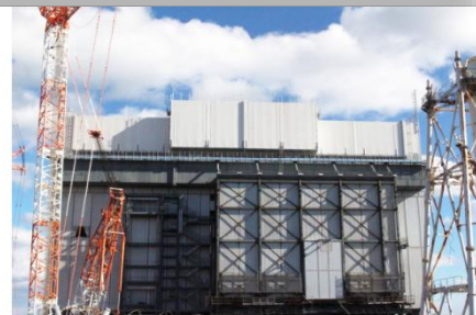
可動屋根設置し、屋根が全閉した時の様子(西より撮影) (撮影日:2026年1月16日)
