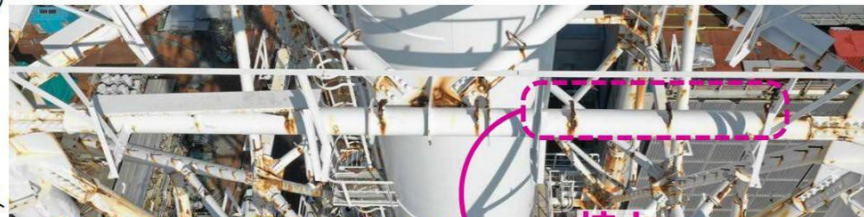
【写真①】地上約76mの南側水平材
