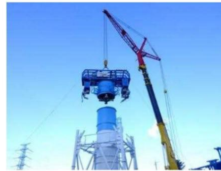
実証試験実施状況（2018.9.28）
