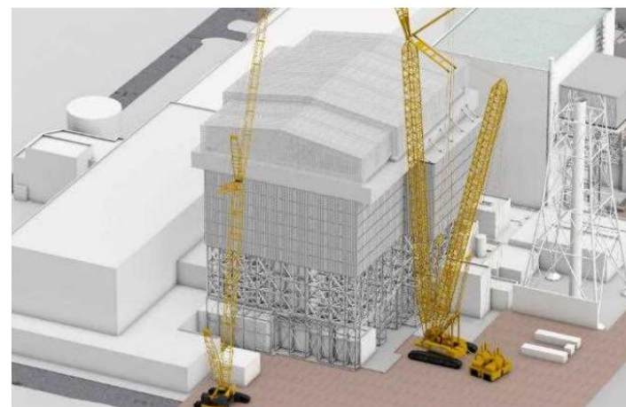
可動屋根設置完了
