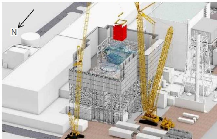
上部架構設置中
