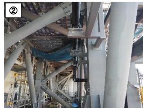
代替注水ライン設置状況 (撮影：2月26日)
