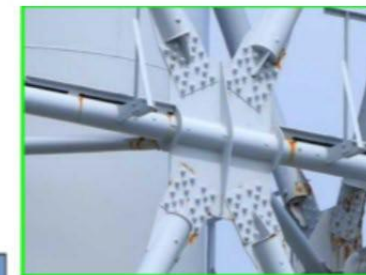
健全と判断した箇所の例
