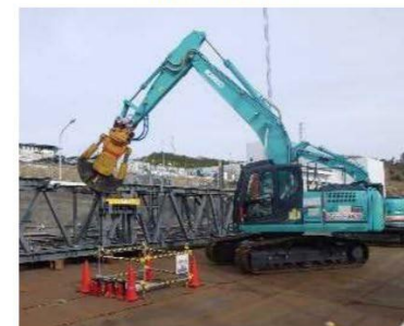
上部解体時の小割解体状況 撮影：2017.4
