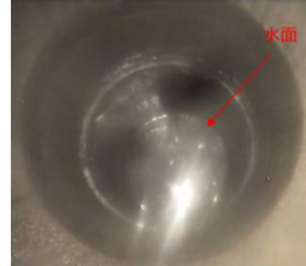
③RCW-Hx(C)入口(垂直)配管の水面
