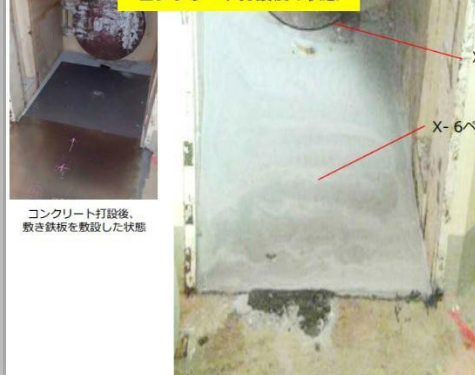
(参考) 2016/11/21 コンクリート打設後の状態
