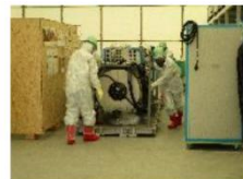
堆積物除去装置 (高圧水、AWJ) 設置
