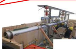
スプレイ治具設置 ※X-53ペネに接続
