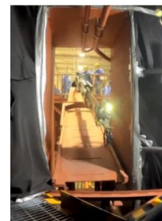
ベDESTAL開口部への装置挿入
