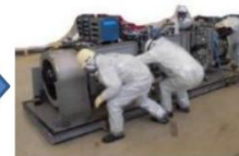
堆積物除去装置 (低圧水) 撤去
