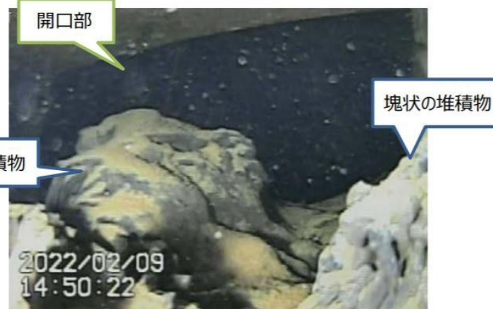
C. ペDESTAL開口部内部
