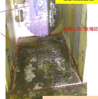
2021/12/6 敷鉄板撤去後
