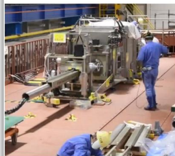
ガイドパイプの挿入
