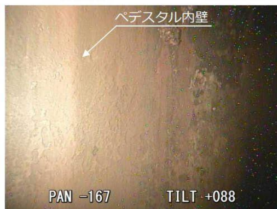
撮影場所D ペDESTAL内壁面
