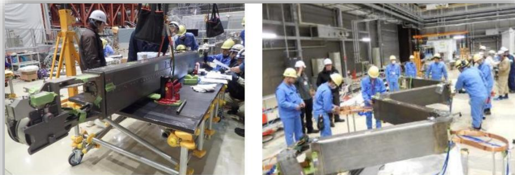
アームメンテナンス・内部ケーブル交換作業状況
