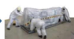
堆積物除去装置 (高圧水、AWJ) 撤去
