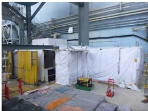
既設装備交換所
