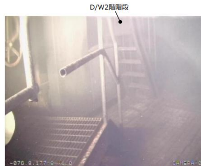
PCVアクセスラート構築作業時(2021年10月15日) PCV水位：約T.P.6500
