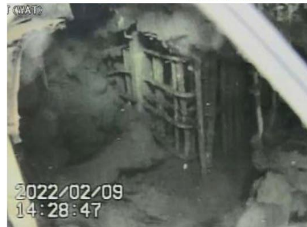
A. ペDESTAL開口部付近
