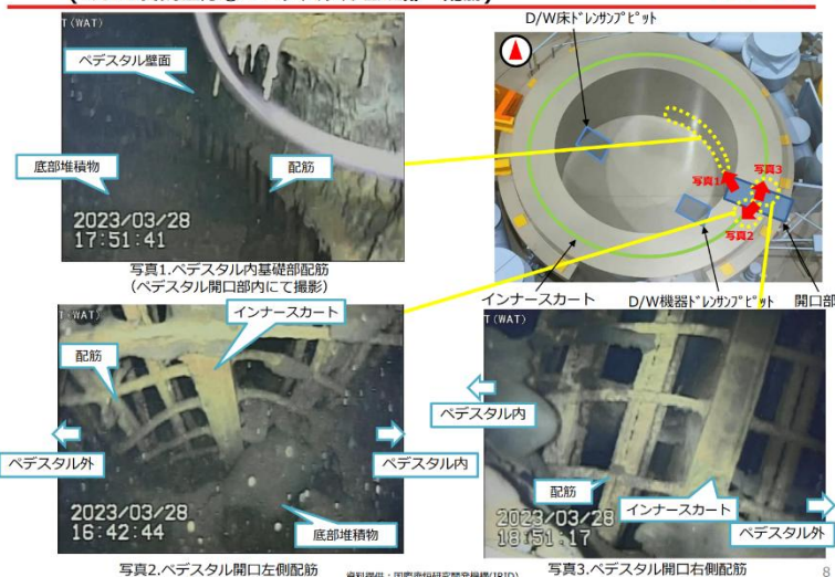
4-1. ペDESTAL外側開口部付近の状況 (3月28日調査①: ペDESTAL基礎部・配筋)
