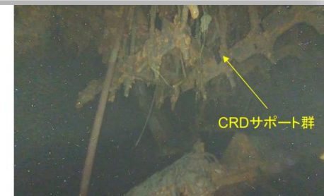
ペDESTAL内入口(3月9日)
