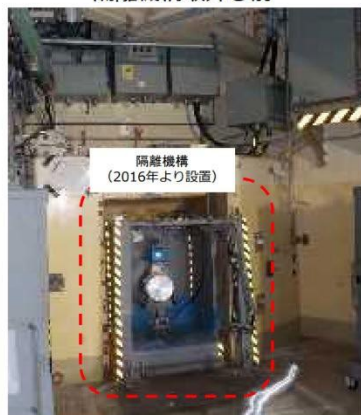
隔離機構取外し前
