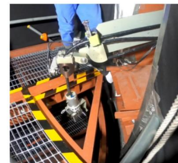
グレーティング開口部からの先端治具吊り下ろし
