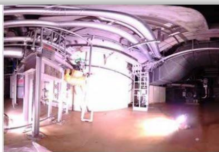
3階シェル壁北東面 (写真)
