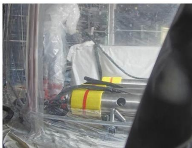
押し込みパイプケーブル入線作業を実施
