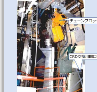
【震災前：定期検査時】CRD交換用開口部前 チェーンブロック
