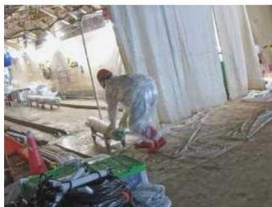
原子炉建屋内1階大物搬入口から 西側通路へ運搬
