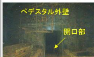
③: CRD交換用開口外観
