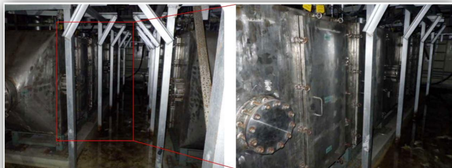
4号機SGTSフィルタレインの様子
