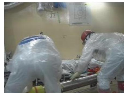
原子炉建屋内1階西側通路からテレ スコピック装置近傍に運搬
