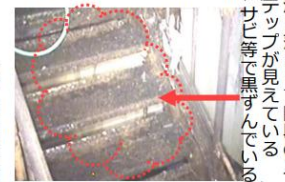
階段室内の作業状況（作業後）
