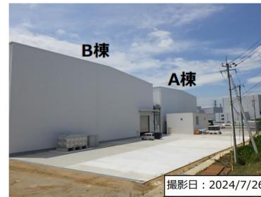
10-A・B棟の外観
