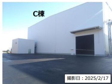
10-C棟の外観
