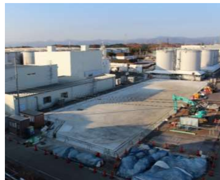
解体完了後 (2025年11月)
