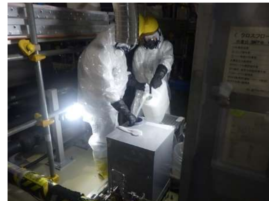
クロスフローフィルター 洗浄作業
