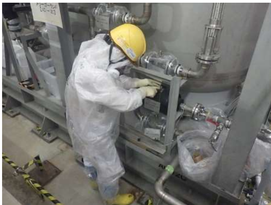
吸着材逆洗作業
