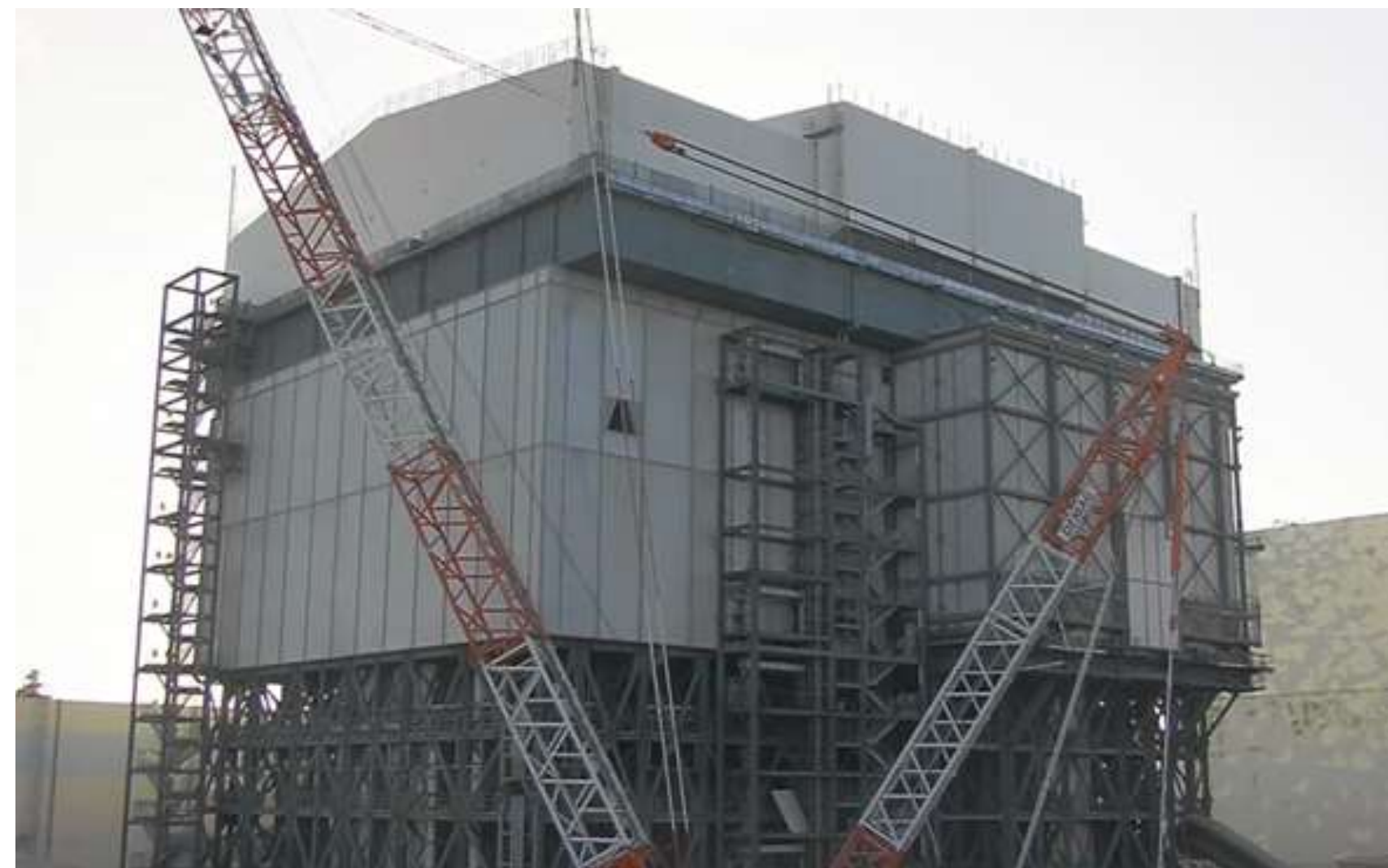
可動屋根設置し、屋根が全閉した時の様子 (撮影日:2026年1月16日)
