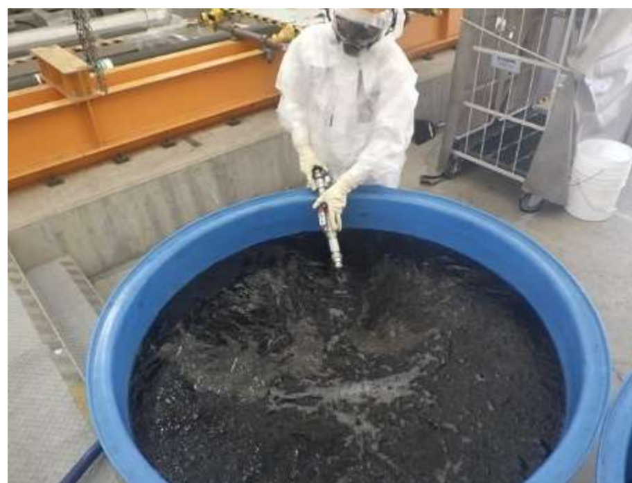
吸着材交換作業
