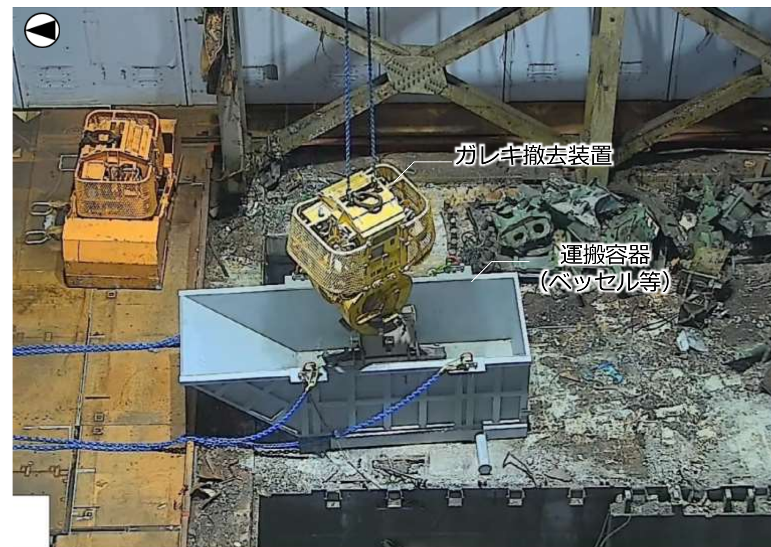
ガレキ撤去の状況（撮影：2026年6月22日）
