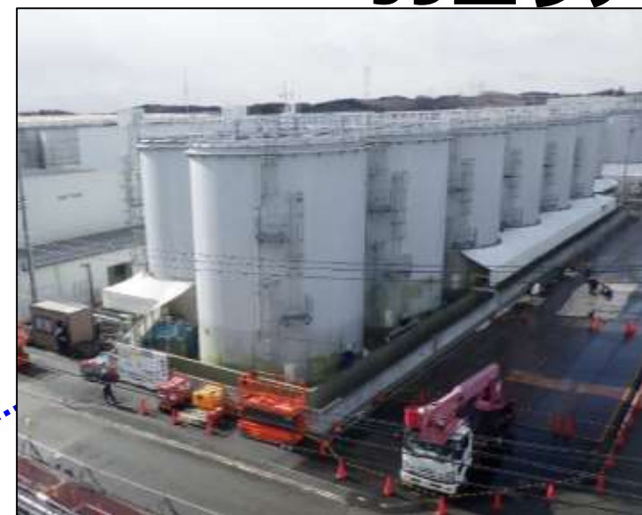
J9エリアのタンク解体
