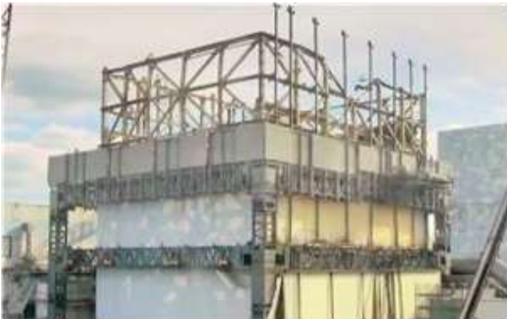
大型カバー設置前の様子 (撮影日:2017年12月19日)
