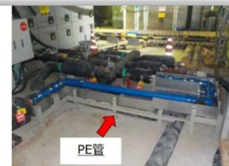
新規PE管施工後
