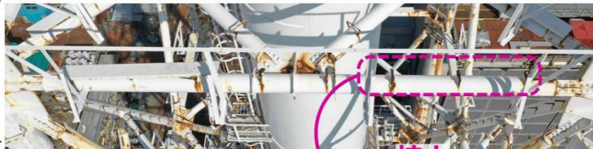
【写真①】地上約76mの南側水平材
