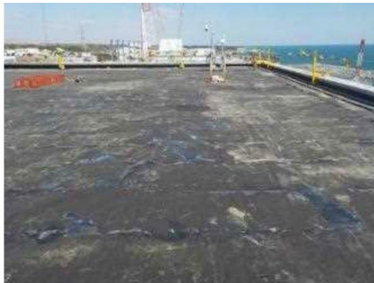
2R/B上屋対策状況
