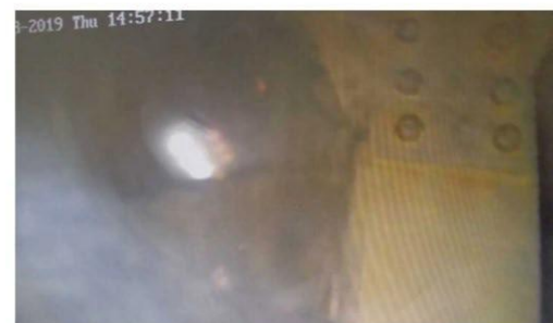
筒身内部支障物（H鋼）写真
