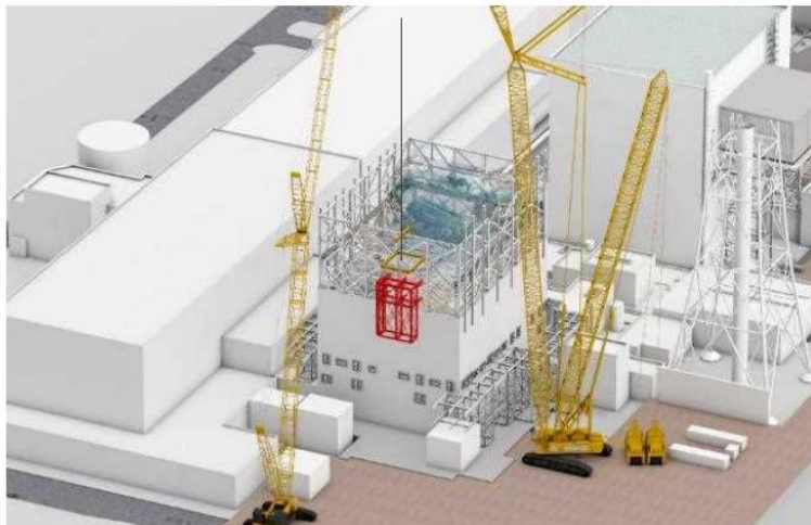
仮設構台設置中
