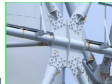
健全と判断した箇所の例
