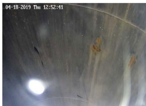
筒身内部調査の実施状況写真
