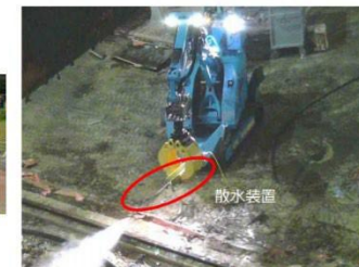
① 散水状況 (ダスト抑制対策)
