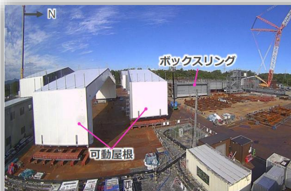
構外西門前ヤード (撮影：2025年9月19日)
