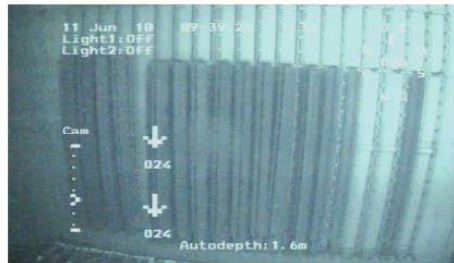
制御棒、制御棒ハンガー全体の様子
