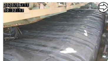
エアモルタル充填（撮影日：2020.6.11）
