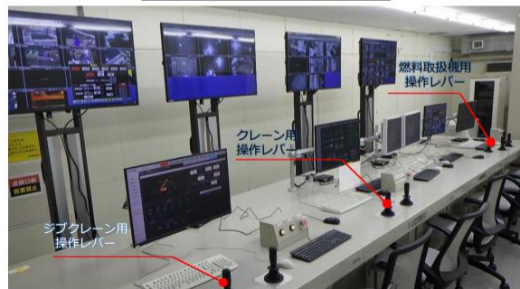
2025年8月22日 遠隔操作室設置状況
