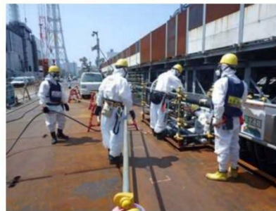
写真③ ケーブル敷設作業状況
