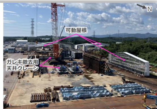
構外西門前ヤード (撮影：2025年9月16日)
