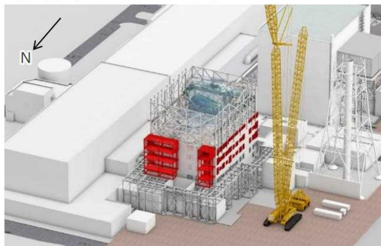
アンカー・ベースプレート設置中
