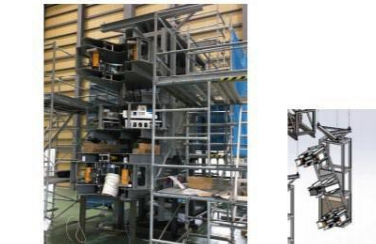
鉄塔解体装置（斜材用）組立状況
