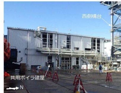
共用ボイラ建屋解体前 (2019年12月撮影)
