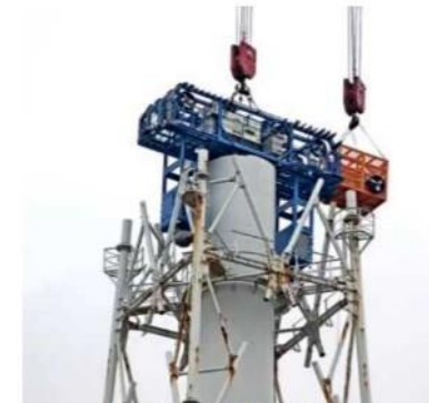
搭乗設備 作業状況
