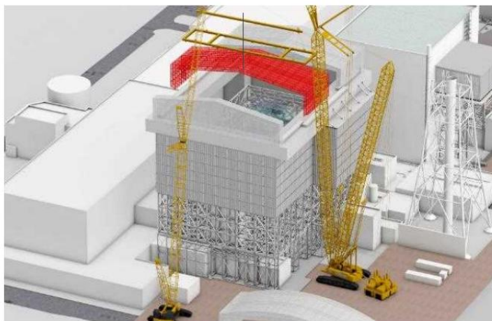
可動屋根設置中
